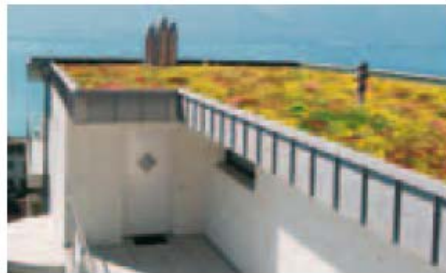
Cubierta ecológica extensiva
