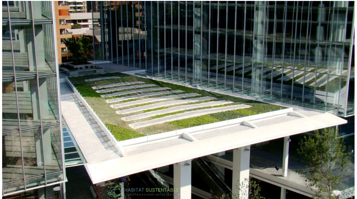
Figura 6-1. Ejemplo Techo Verde extensivo con prestaciones ambientales Cambio Climático en Santiago, realizado el año 2012 por Habitat Sustentable Ltda y Sistema tecnológico ZinCo. (Fuente propia del año de primera mantención 2013)
