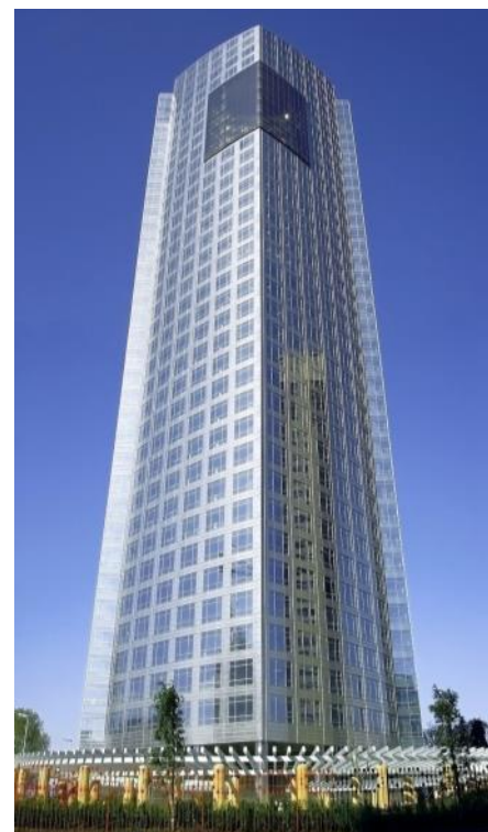
La torre de oficinas de 160 m de altura se eleva hacia el cielo.
