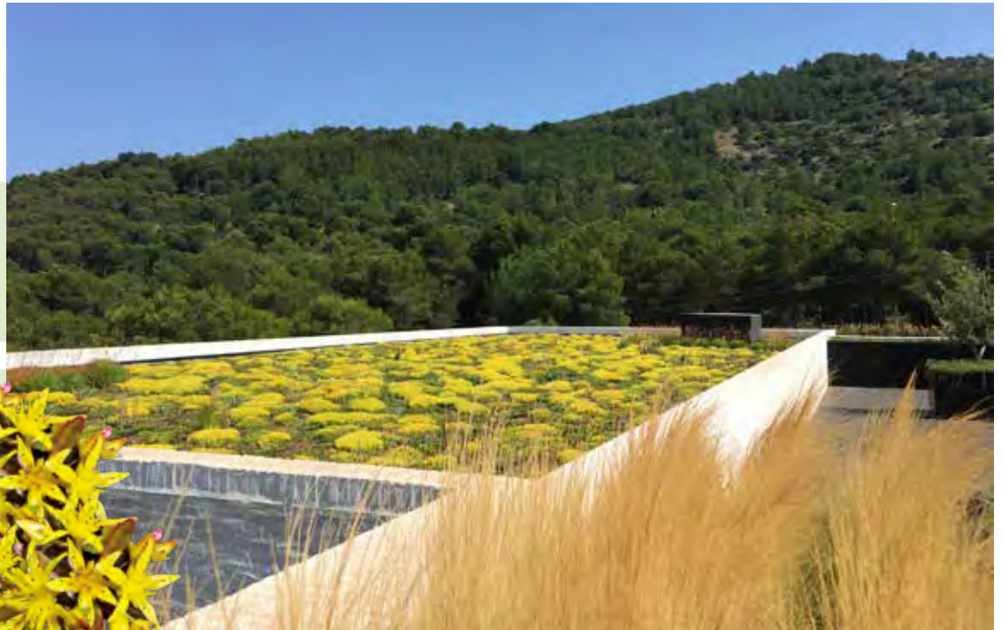
Cubierta extensiva en Andalucía
