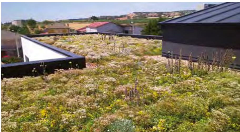
Cubierta extensiva en Burgos
