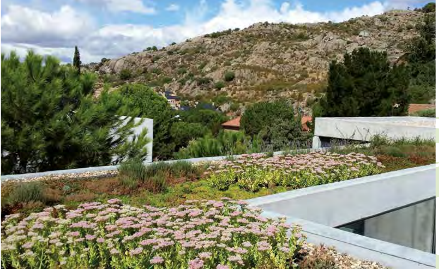
Cubierta verde en la provincia de Madrid
