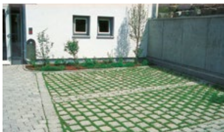
Juntas verdes de una superficie adoquinada
