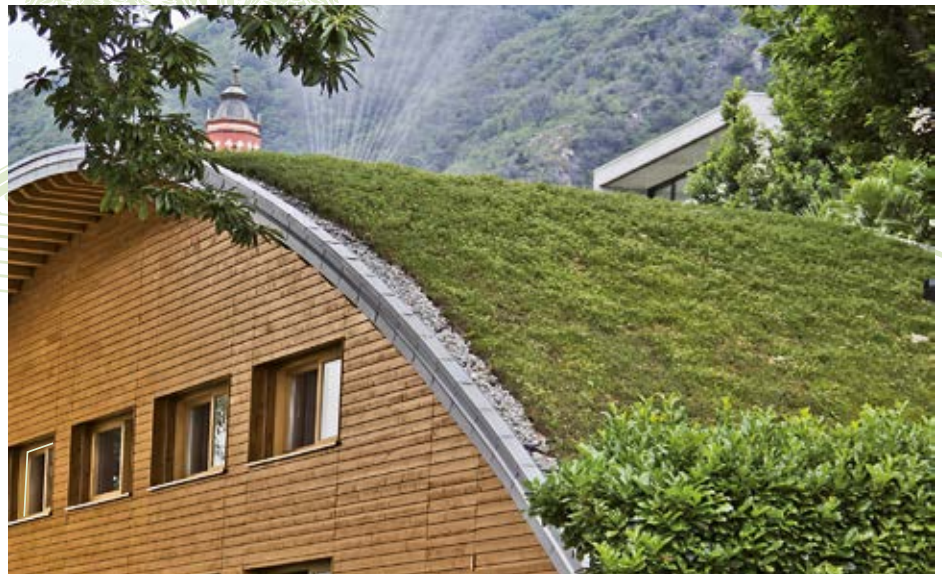
Cubiertas inclinadas requieren medidas especiales para proteger la vegetación.
