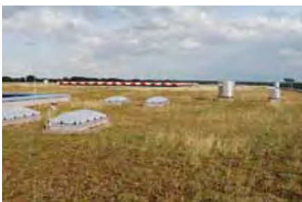
El sistema convencional de cubierta verde extensiva (de tipo "Sedum tapizante") evapora 20–50 litros al día durante el verano.
