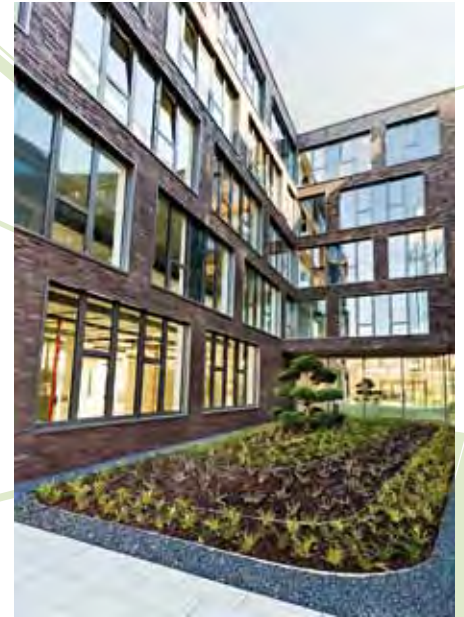
Patio realizado con el sistema “Cubierta reguladora de cargas pluviales” sobre un garaje subterráneo en la ciudad de Ratingen, Alemania
