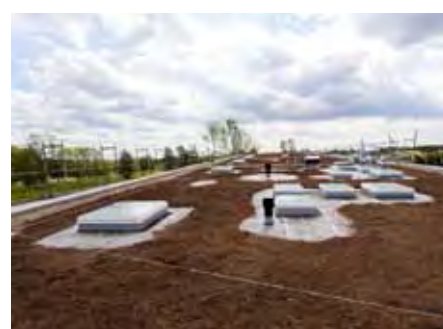
El sustrato Zincoterra "Tapizante floral" instalado sobre la cubierta.
