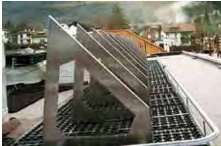
Soporte de 45° para placas térmicas solares en una cubierta con pendiente de 5°.
