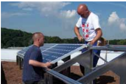
5. Se instalan los paneles solares.
