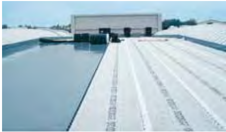
1. La impermeabilización de la cubierta se cubre con la lámina de protección, y el elemento de drenaje y retención de agua Fixodrain® XD 20.
