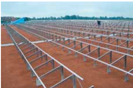
4. Se cubren las Bases Solares con ZincoTerra según la carga requerida en el proyecto.
