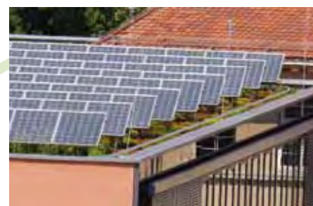
Los sistemas de energía solar se instalan hasta el borde de la cubierta para aprovechar la máxima área de cubierta disponible. Con el Rail Fallnet® SB 200, se puede trabajar con total seguridad en los bordes de la cubierta.
