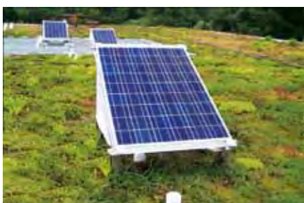
La prueba consistió en comparar dos módulos instalados sobre superficies bituminosas "desnudas" frente a un módulo instalado en una cubierta verde. El objetivo era comparar las respectivas temperaturas bajo los módulos
