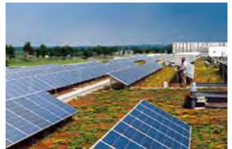
6. Cubierta completamente instalada: cubierta verde con sistema de energía solar.
