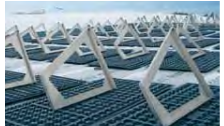
3. Los soportes de base solar SGR se fijan mecánicamente en las bases solares ZinCo y se alinean.
