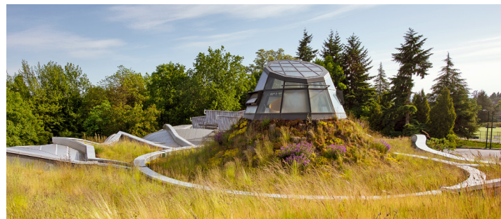
ZinCo® Centro de interpretación Jardín Botánico VanDusen con Sistema tecnológico de techos verdes inclinado hasta < 20° (36%) con Floraset® FS 75. (estructura de cubierta alabeada)
