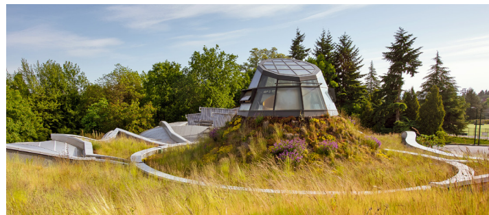
ZinCo® Centro de interpretación Jardín Botánico VanDusen con Sistema tecnológico de techos verdes inclinado hasta < 20° (36%) con Floraset® FS 75. (estructura de cubierta alabeada)
