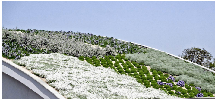
ZinCo® Bodegas Viñedo Ramón de Bilbao con Sistema tecnológico de techos verdes inclinado hasta < 20° (36%) con Floraset® FS 75 (estructura de cubierta abovedada)
