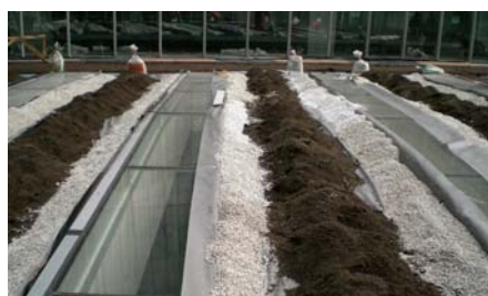
El sustrato y las gravas (a lo largo des los bordes) se distribuyen uniformemente por toda la superficie del cubierta.
